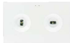
Lente pasillo (cruce techo)
