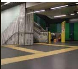
Loges permite al diseñador crear una ruta racional y estructurada, a través de la cual las personas con discapacidad visual se desplazan de manera adecuada y pueden moverse por sí sola y lograr total autonomía al recorrer estas áreas.
