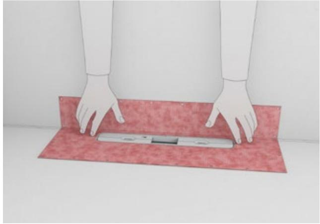
**Paso 4:** Sellado con un solo clic: una vez se haya aplicado el solado, debe extraerse la primera parte de la protección para pared de obra del sumidero e introducirse el collar de sellado suministrado mediante el mecanismo de clic. Hecho esto, ya es posible pasar a la fase de sellado y alicatado de la zona de ducha.
