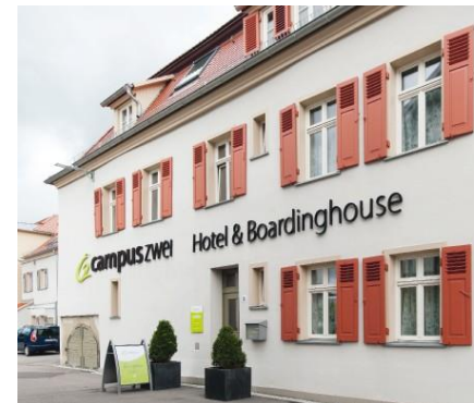
Hotel & Boardinghouse Campuszwei, D-Ludwigsburg Arquitecto: Claudia Senner, D-Pfullingen Operador: Servicio al huésped y empresa hotelera
